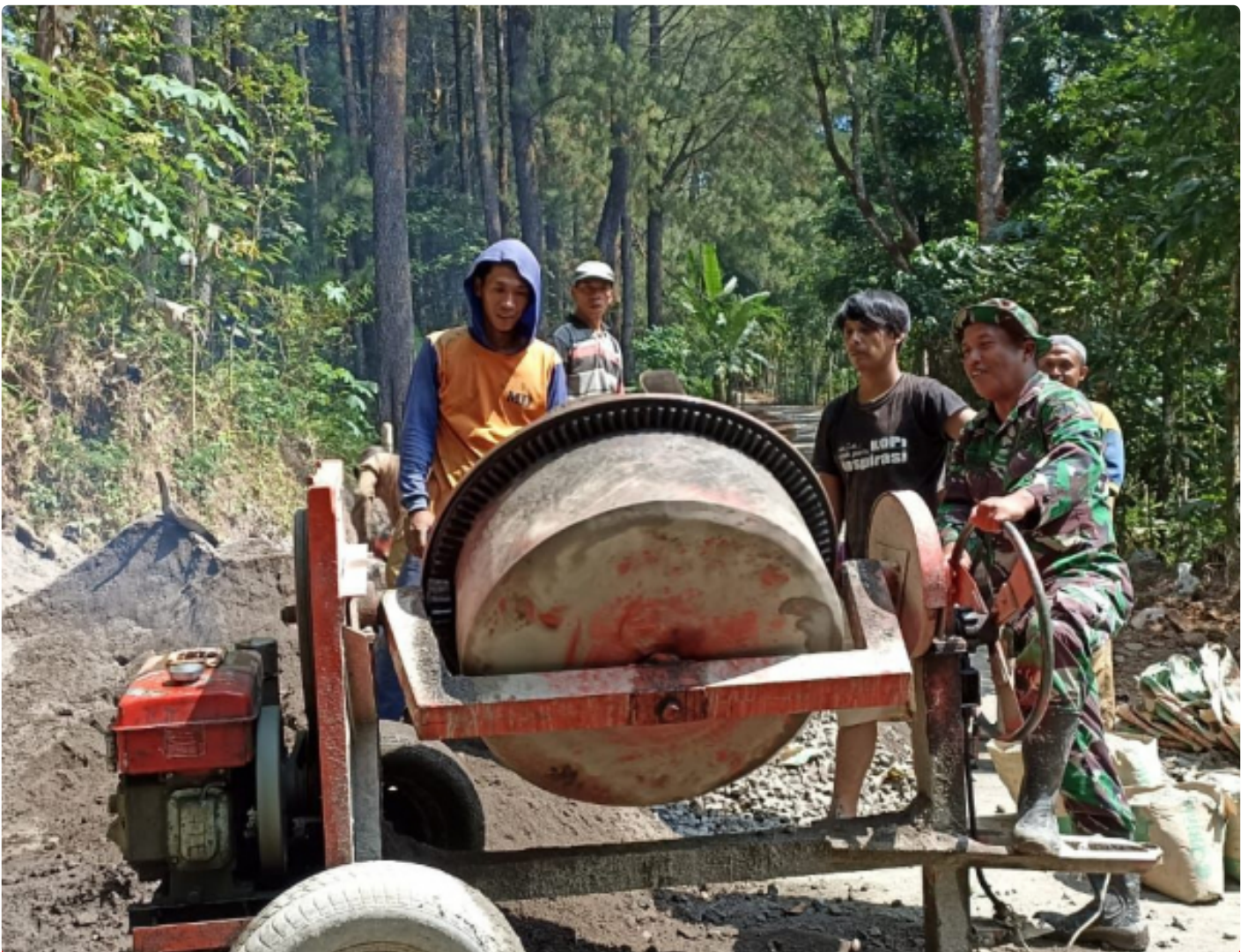
Satgas TMMD kebut pengecoran jalan
